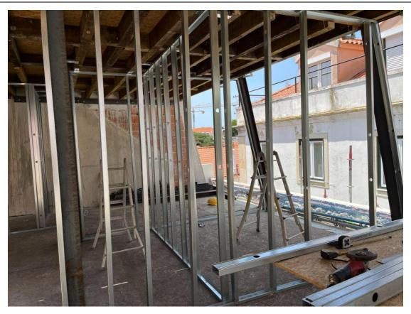
6 月,建筑商继续组装内部分隔墙的钢结构,以分割和定位公寓的空间和功能区。我们在一楼完成安装,并在二楼开始工作。
