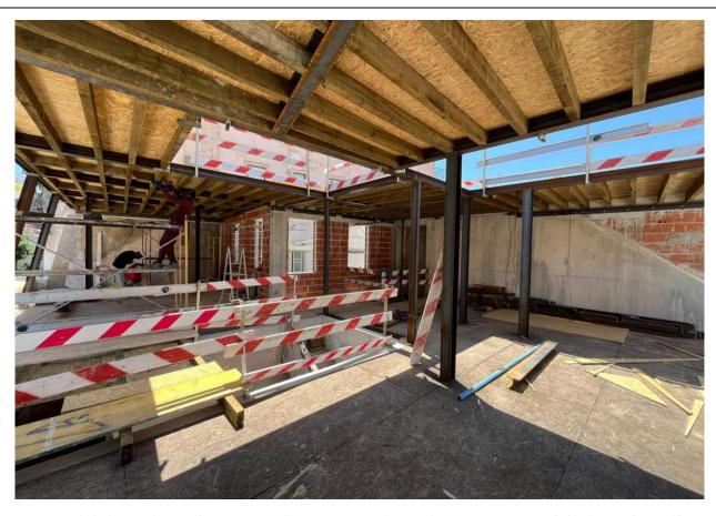
继上次报道中提到的工作之后,施工人员正在继续进行三层钢结构的组装工作。 钢结构完成后,我们开始放置木梁和木板,完成主体结构和路面板,然后准备安装屋顶。
