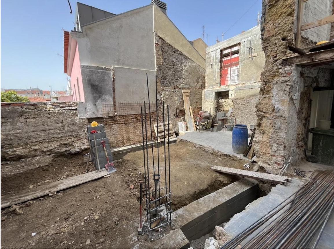
正如之前的报道中提到的，施工人员挖掘了地基，以加固新的结构基础。9月份，一层薄薄的混凝土被铺设到用作地基的地下室，之后开始逐步安装钢筋和制作木质模具，然后施工人员将混凝土倒入模具中，在10月份建造完成了地基脚。
