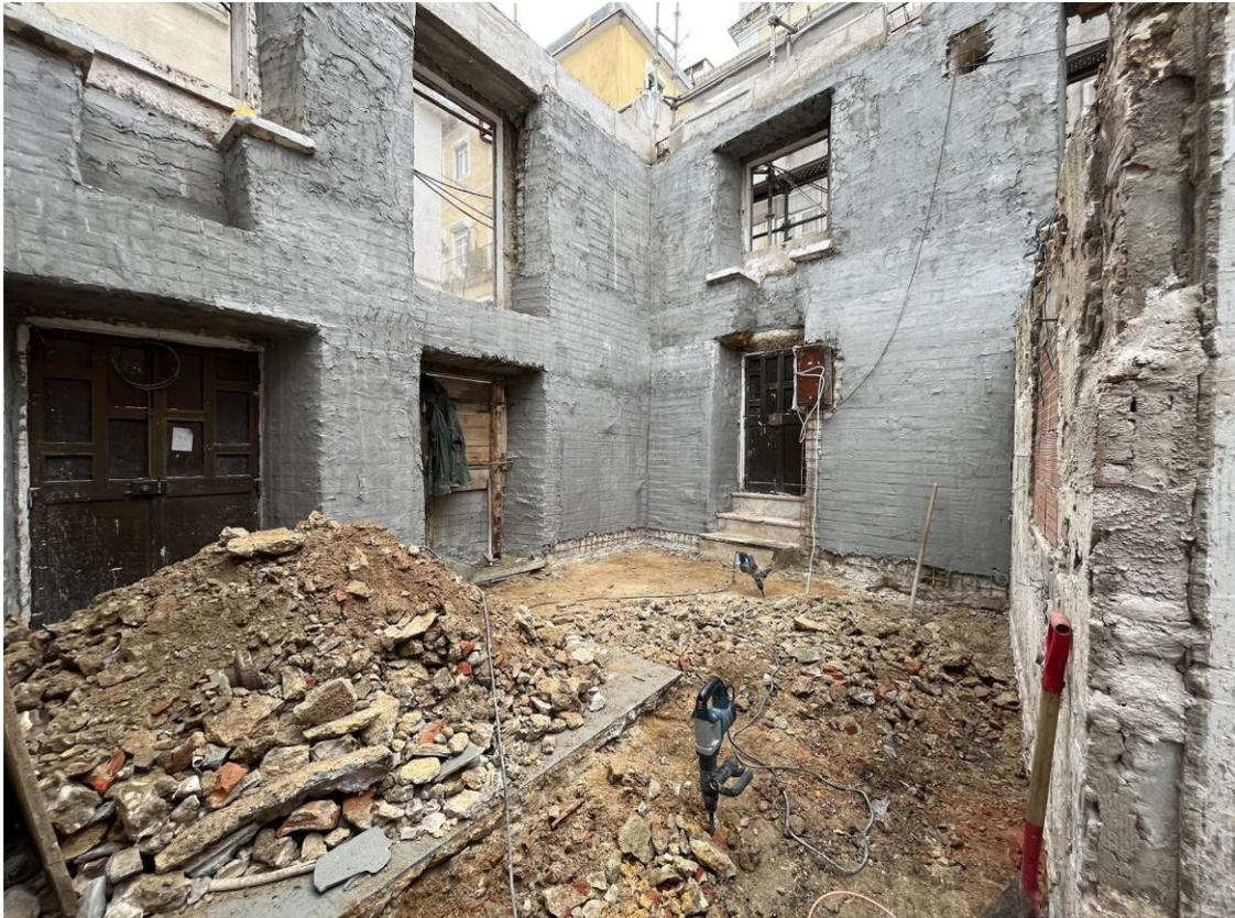
施工人员拆除了原有立面墙体的旧石膏，然后填充墙体裂缝的空隙，并在墙壁上铺设网格，铺设钢筋石膏作为墙壁的保护。10月，我们完成了内墙的结构加固。
