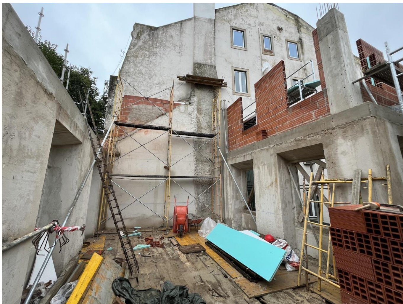
2樓外牆於 10月完工。同時，施工人員用磚塊擴展了與下一棟建築相連的現有牆壁。
