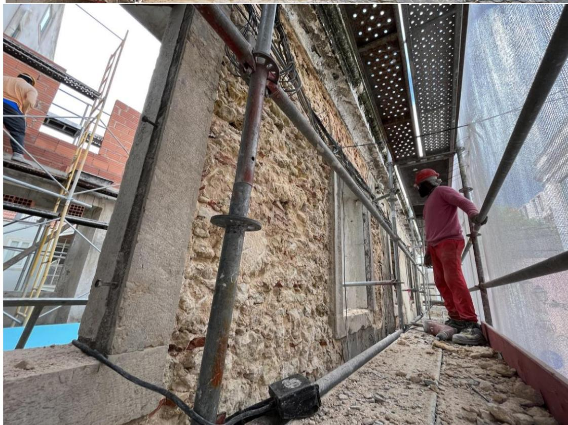
与此同时，施工人员开始将那些旧有的石膏从立面墙上拆除，然后填补空隙，稍后再次在上面涂抹加固石膏。
