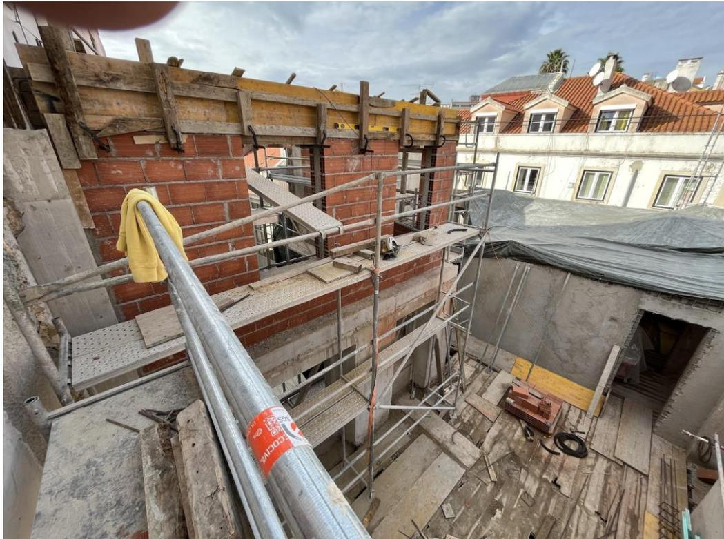
10 月，施工人员完成了钢筋结构和木制模具的组装，并浇筑混凝土形成顶梁，将所有打桩平铺在一起，为下一步打下基础。我们继续在梁上安装柱子和砖块，从二楼到三楼建造混凝土结构。
