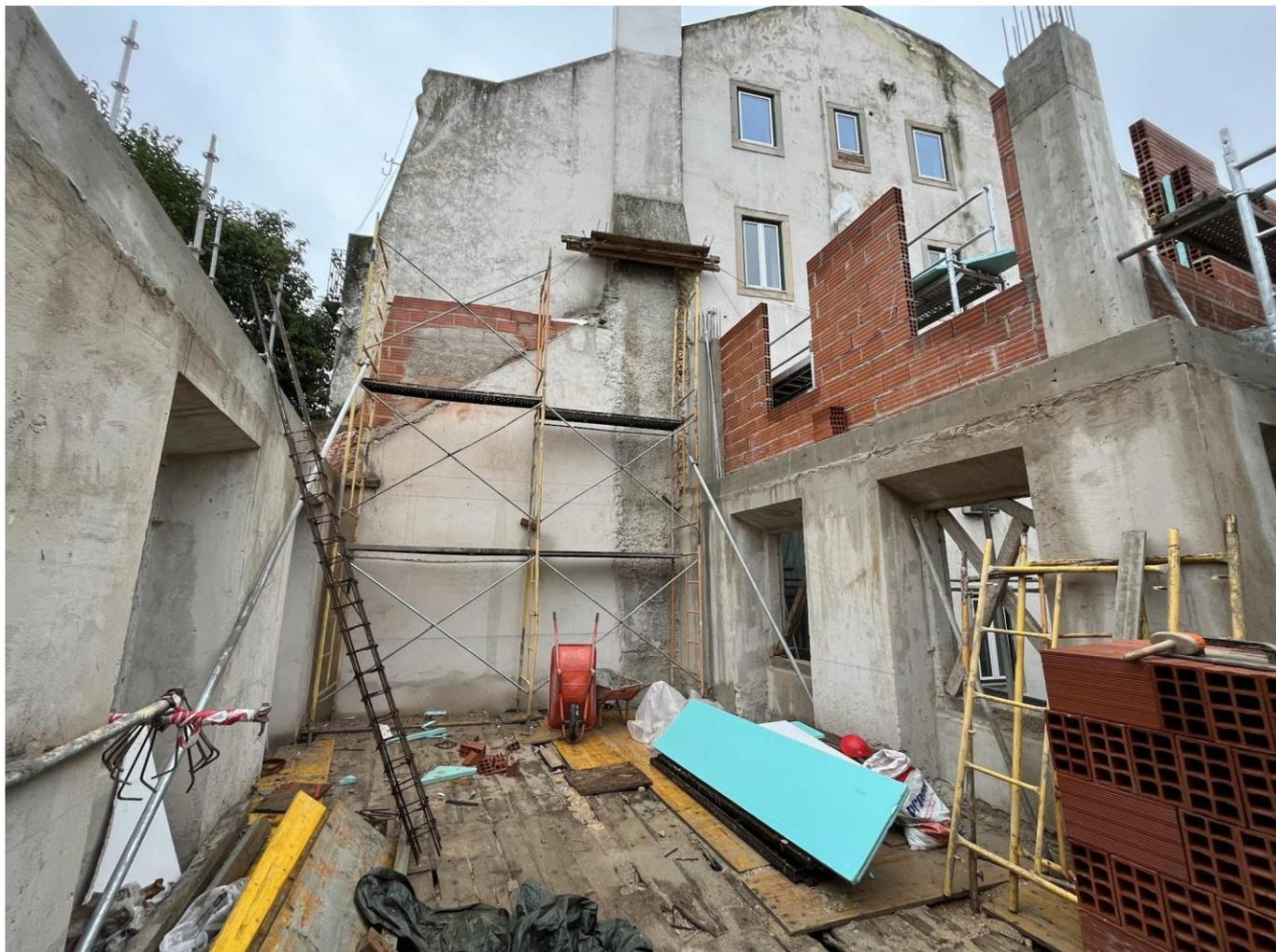
**2 楼外墙于 10 月完工。同时，施工人员用砖块扩展了与下一栋建筑相连的现有墙壁。**
