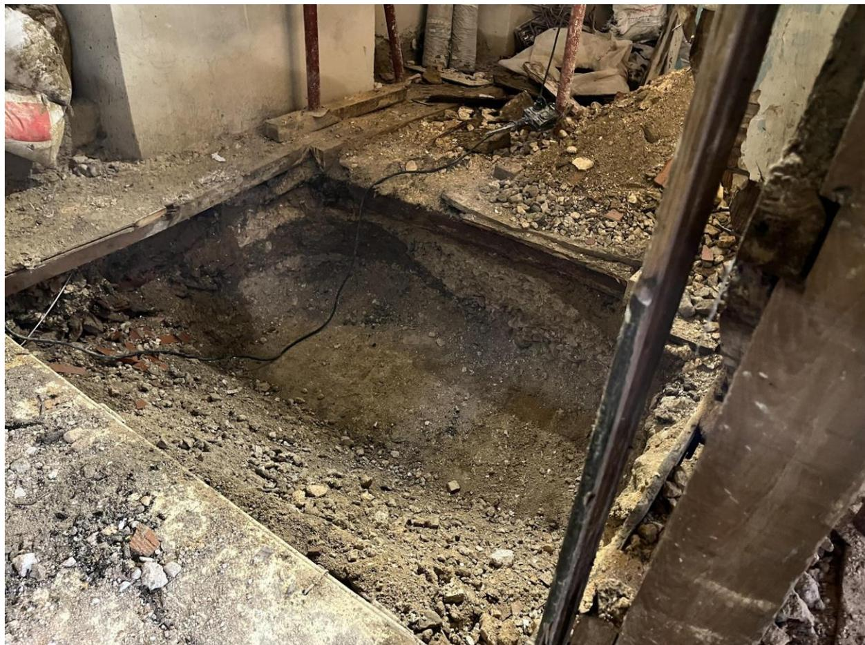
按照工作计划，施工人员正在挖掘建筑基础的地基，以建造钢结构在未来加固整个建筑结构。
