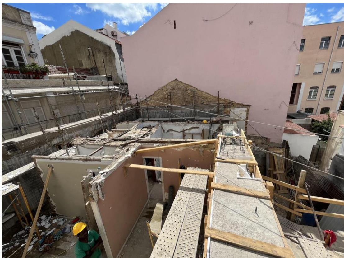
正如八月份的施工報告中提到的，施工人員正在建造封頂梁工作。9月，我們完成了鋼結構和木模的組裝，澆注混凝土，在現有建築物的頂部建造外牆頂梁，以加強外牆結構，避免未來倒塌。
