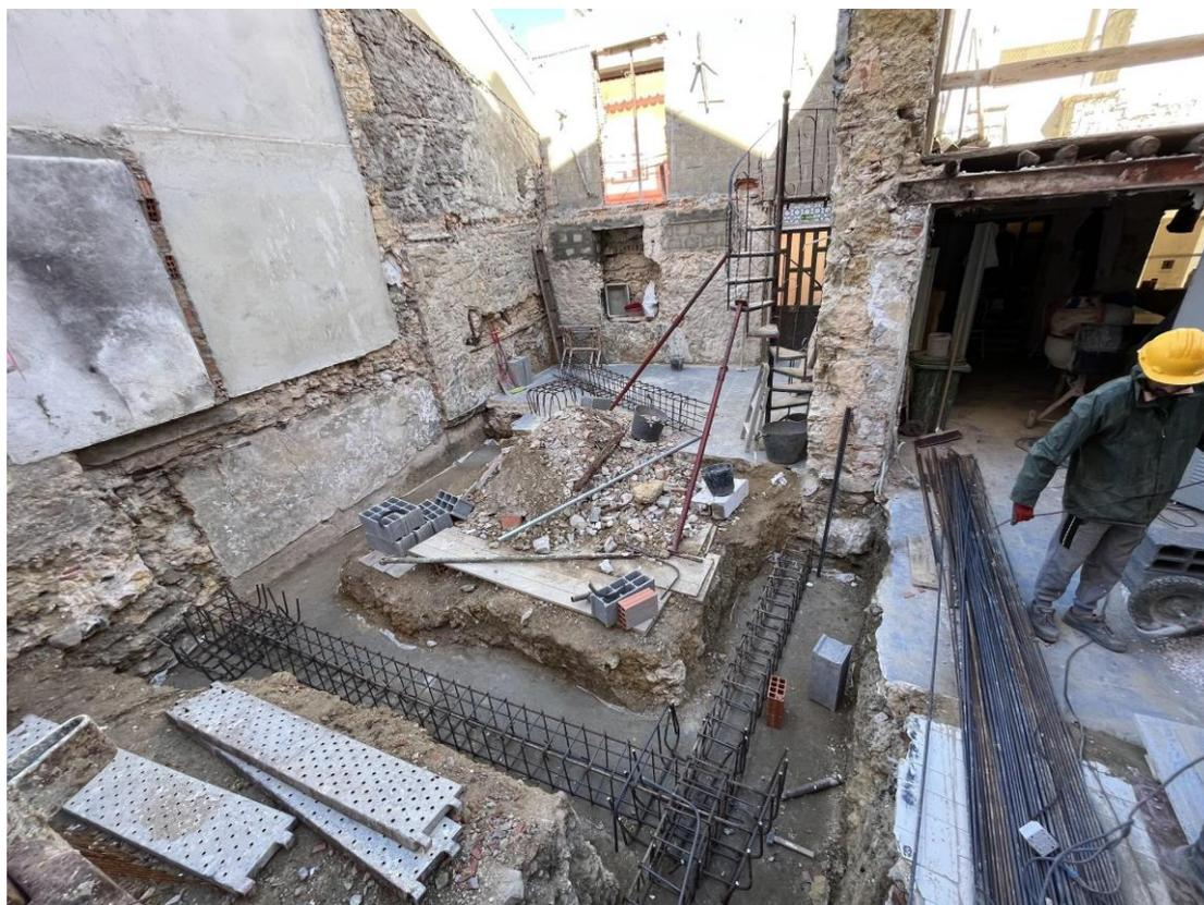
八月底，施工人員完成了一次徹底挖掘，達到了這座建築的最低水平面。9月，我們繼續挖掘地基，以增強新結構的建築基礎。在這些步驟後，塗上一層混凝土作為建築的地基，然後安裝鋼筋。
