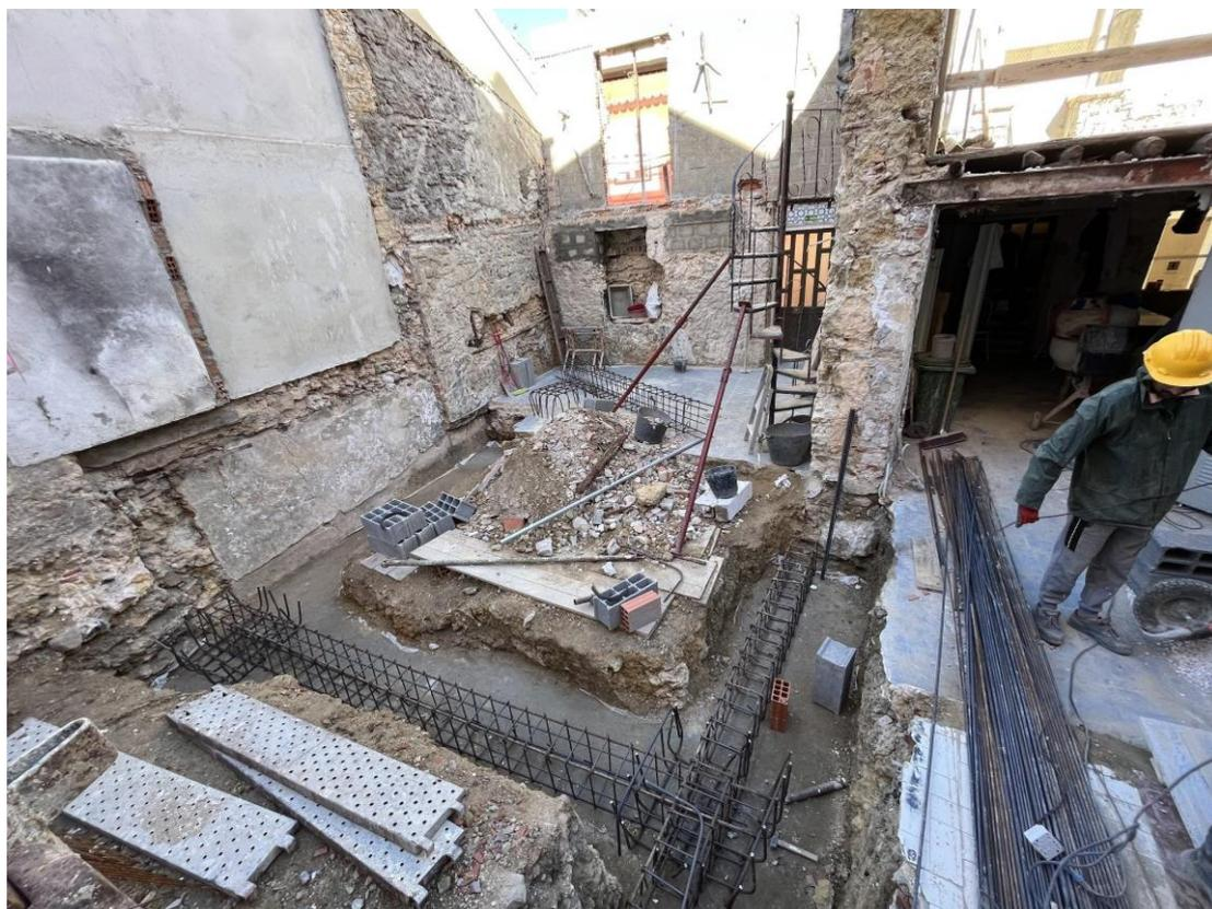
八月底，施工人员完成了一次彻底挖掘，达到了这座建筑的最低水平面。9月，我们继续挖掘地基，以增强新结构的建筑基础。在这些步骤后，涂上一层混凝土作为建筑的地基，然后安装钢筋。
