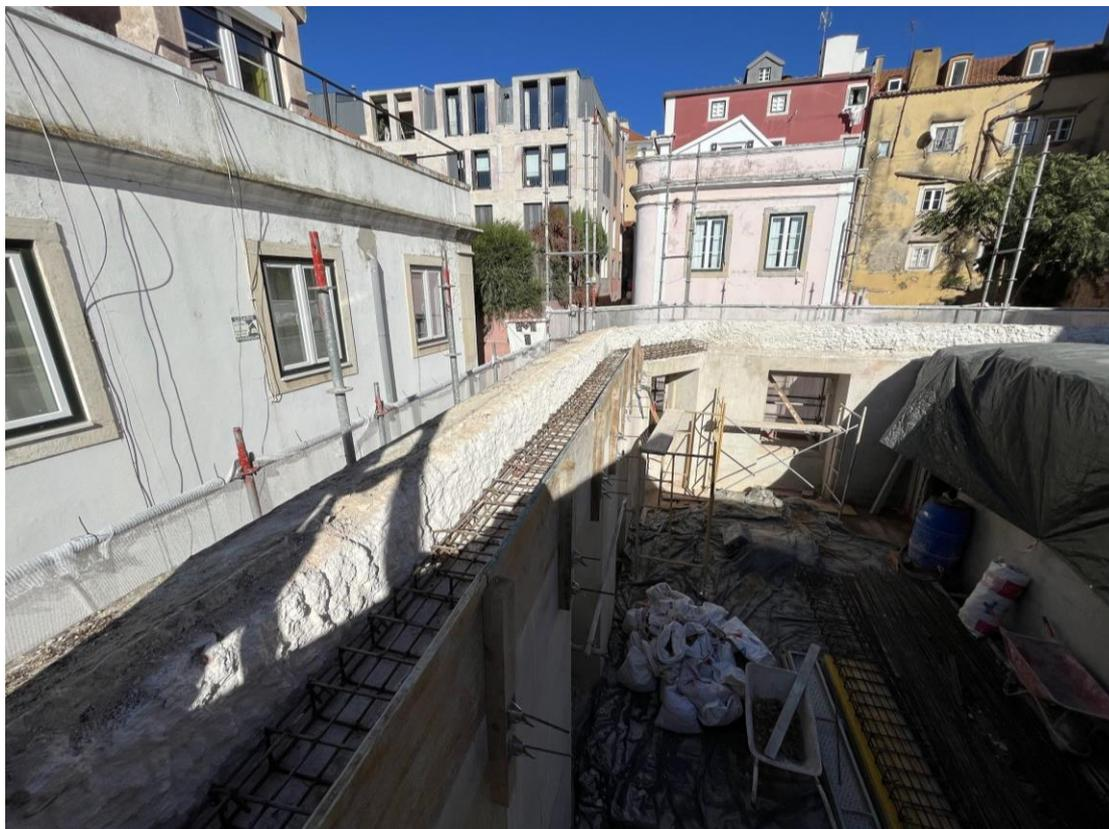
正如上一份報告中提到的，施工人員拆除了更多的上層舊牆體，以準備使用由鋼和混凝土製成的封頂梁，將所有的打樁平鋪在一起，為下一步打下基礎。9月，我們繼續在梁上安裝柱子和磚塊，以重建面向花園的建築物的外牆。與此同時，我們開始準備在前立面牆上建造封頂梁。
