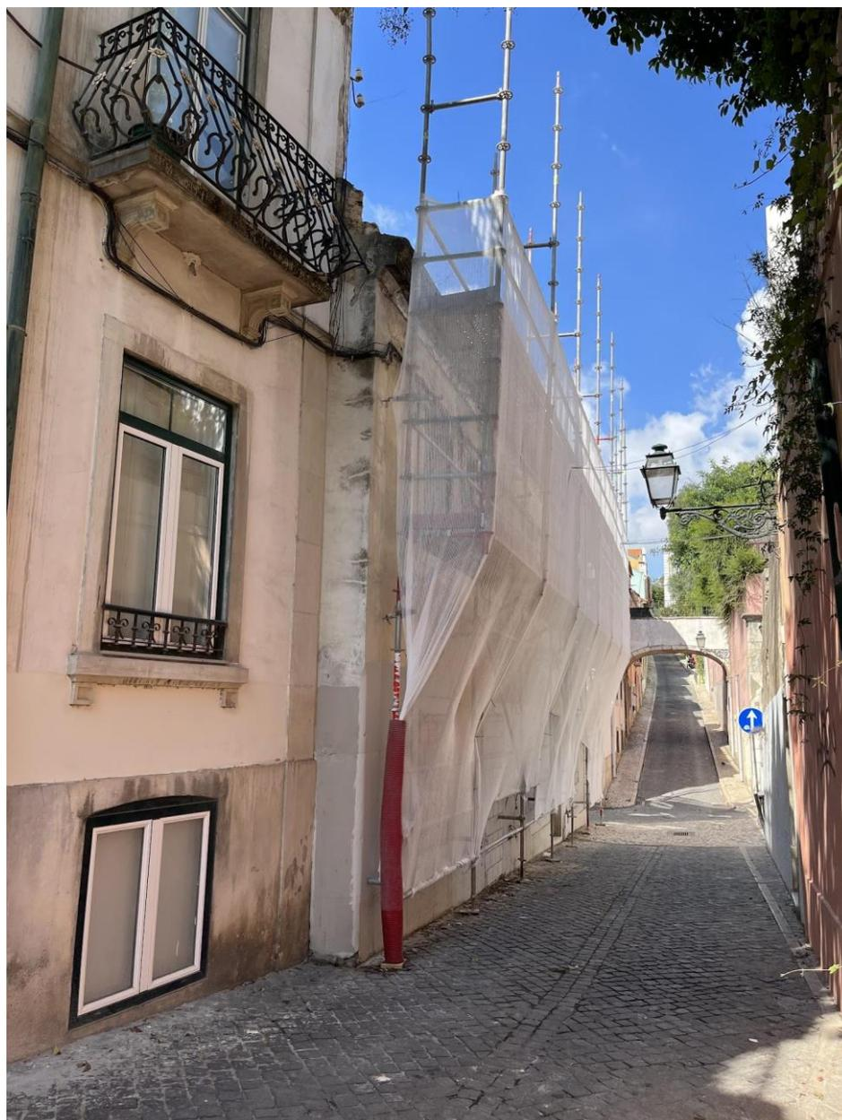
按照計畫，施工人員在前立面上安裝了工程棚架，以更好地在工地工作並保護建築物的立面。
