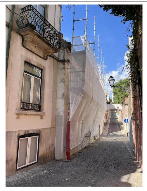
按照计划,施工人员在前立面上安装了工程棚架,以更好地在工地工作并保护建筑 物的立面。
