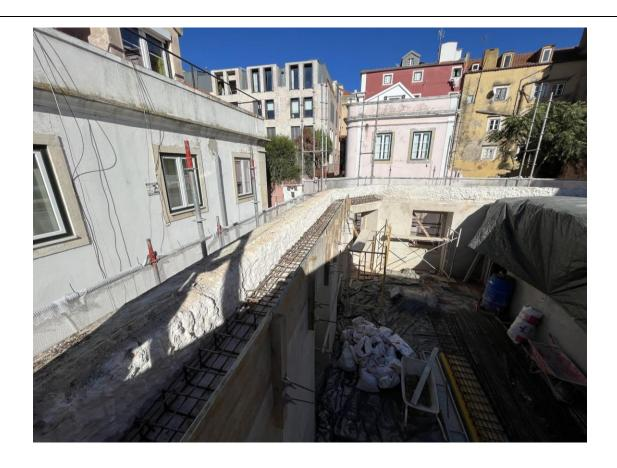
正如上一份报告中提到的,施工人员拆除了更多的上层旧墙体,以准备使用由钢和 混凝土制成的封顶梁,将所有的打桩平铺在一起,为下一步打下基础。9 月,我们 继续在梁上安装柱子和砖块,以重建面向花园的建筑物的外墙。与此同时,我们开 始准备在前立面墙上建造封顶梁。
